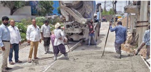
పనులను పరిశీలిస్తున్న కార్పొరేటర్ డౌడ్ వెంకటేష్ గౌడ్
